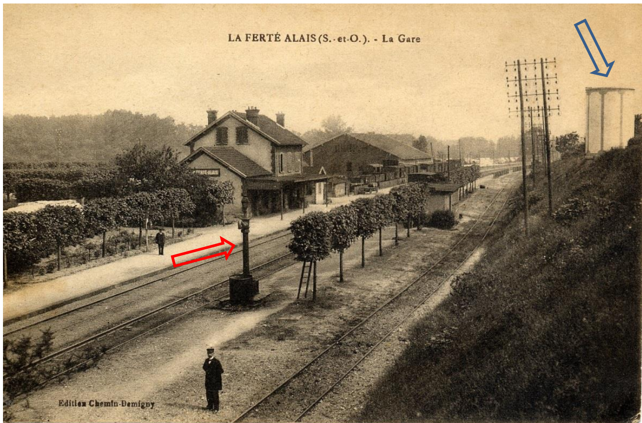
Sur cette carte postale on distingue bien, au centre, le point de remplissage en eau des locomotives à vapeur de la ligne PLM (flèche rouge.) Le réservoir d'eau était situé à droite sur le talus (flèche bleue). Collection privée.
