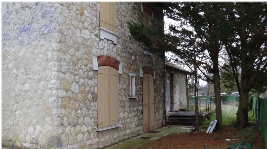
L'architecture des gares du Tacot (ici celle de La Ferté-Alais) est toujours la même : construction en pierres apparentes, linteau des portes et fenêtres en arc de briques rouges. Au rez-de-chaussée, l'entrée du hall de gare se fait toujours par la porte de droite, la halle à marchandises est située à droite de la gare. Hormis celle d'Orveau, les gares de cette ligne possèdent également un étage, utilisé en appartement. Photo HAF.
