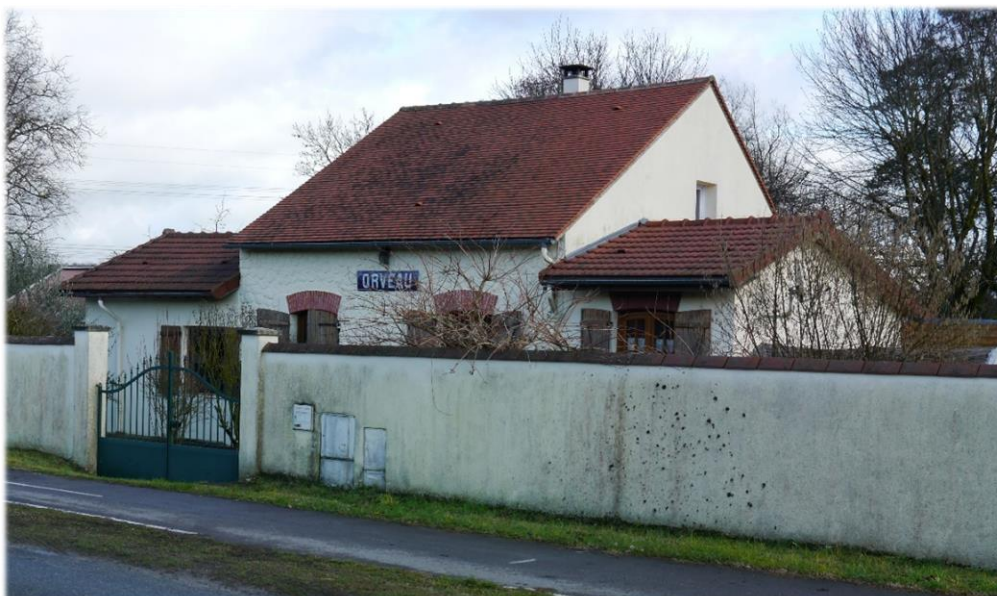
L'ancienne gare du Tacot d'Orveau a conservé son panneau ainsi que sa halle à marchandises à droite. L'extension d'habitation à gauche a été construite ultérieurement. Photo HAF.
